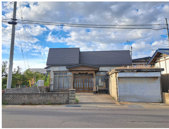
空き家の外観及び内観
