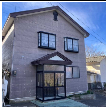
空き家の外観及び内観
