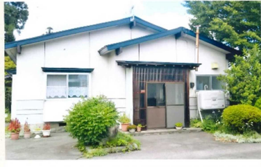
空き家の外観及び内観
