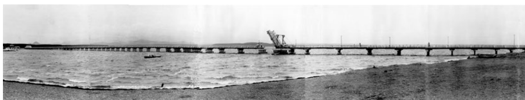
図169 昭和34年（1959）8月完成の十三橋
