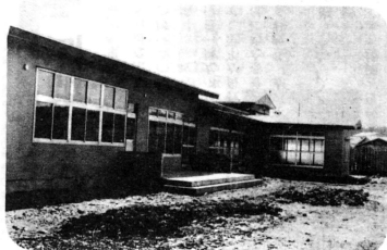
磯松公民館 木造モルタル平屋建て 335㎡。58畳の大広間は冠婚葬祭に利用できるほか、老人室には風呂呂湯がついている。工事費は12,800千円。
