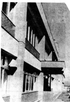
十三小学校 鉄筋コンクリート二階建て 1,500㎡。屋体は鉄骨平屋建て 441㎡。工事費は 121,700千円。
