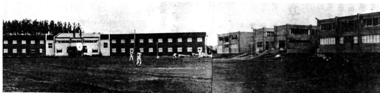
市浦中学校 (校舎) 鉄筋コンクリート二階建て 2,793㎡。(屋体) 鉄筋コンクリート二階建て 925㎡。 (寄宿舎) 鉄筋コンクリート二階建て433㎡。鉄骨平屋建て292㎡。木造二階建て924㎡。工事費は211,330千円。 (寄宿舎増築) 木造二階建て272㎡。工事費は7,400千円。
