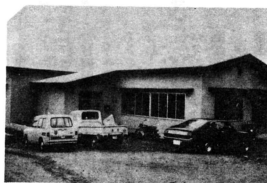
郷土資料館 木造モルタル平屋建て 219㎡。工事費は 8,720千円。
