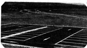
十三湖駐車場 アスファルト舗装864㎡。駐車台数39。工事費3,000千円。
