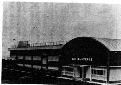
脇元小学校 鉄筋コンクリート二階建て 1,239㎡。屋体は鉄骨平屋建て 406㎡。工事費は校舎56,558千円。屋体16,049千円。
