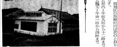
脇元小学校の給食室が完成した。
