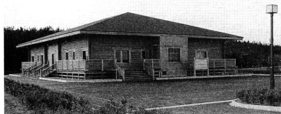
▲完成した十三地区漁業集落排水施設「水の館」
