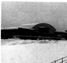
相内・実取地区に建設中の 総合交流促進センター
