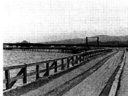
昭和30年代、市浦村の礎を一つにした十三橋の完成
