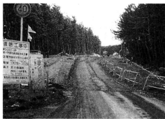
着々と工事が進む 県道跡ヶ沢蟹田線 (十三・栗山間)
