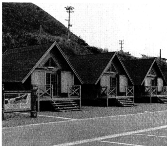
このほど完成したバンガロー
