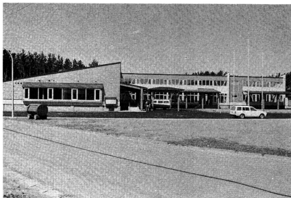
大型木造施設として注目を浴びている役場庁舎は、昭和63年5月23日開庁しました。
