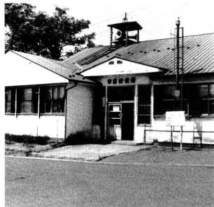
昭和32年度に仮庁舎として建設された現在の役場庁舎
