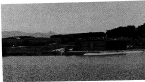
相内の大沼地区に建設されている艇庫。
