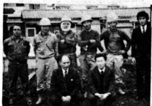
協信機工では宅地造成をしています
