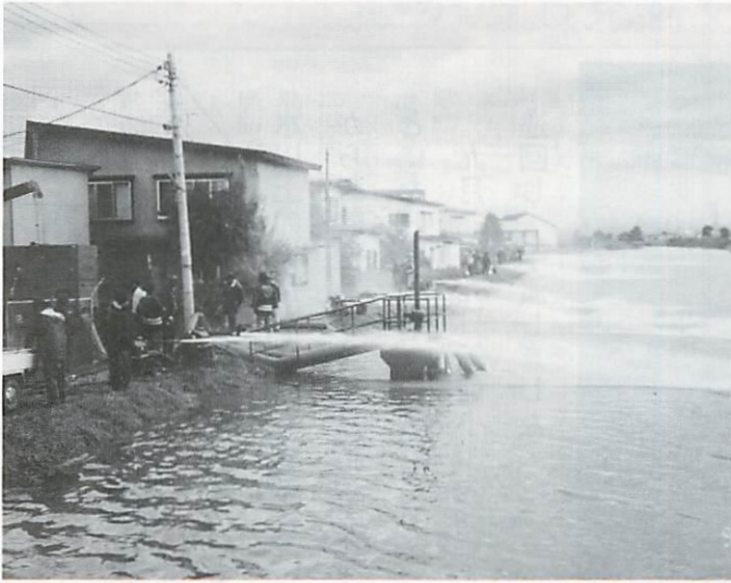
鎌谷橋から見た、石岡地区(五商高北側)のポンプによる排水作業
