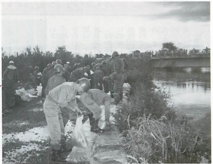
溢水のおそれの出てきた新十川・中泉橋上流部での土のう積み作業
