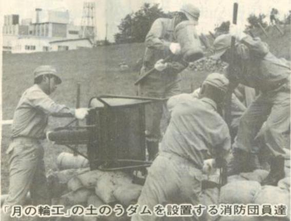
『月の輪工』の土のうダムを設置する消防団員達
