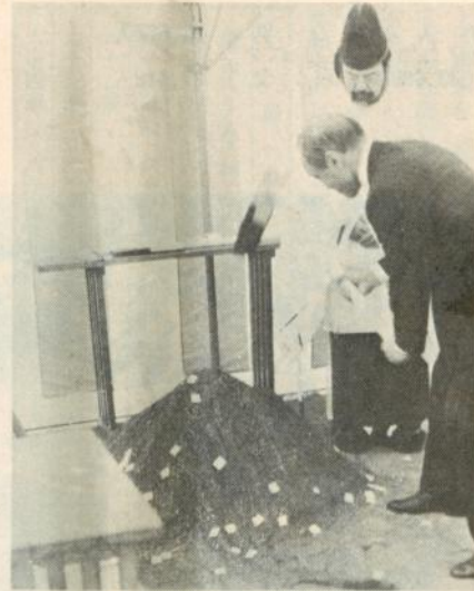
働く婦人の家、建設現場で
