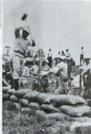
は、堤防が浸水した場合を想定したむしろ張り工法や流水を緩和して堤防の崩壊の拡大を防ぐ木流し工法、漏水を防ぐ積土のう、月の
