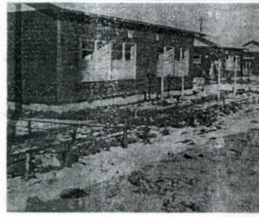
住宅建設の様子
