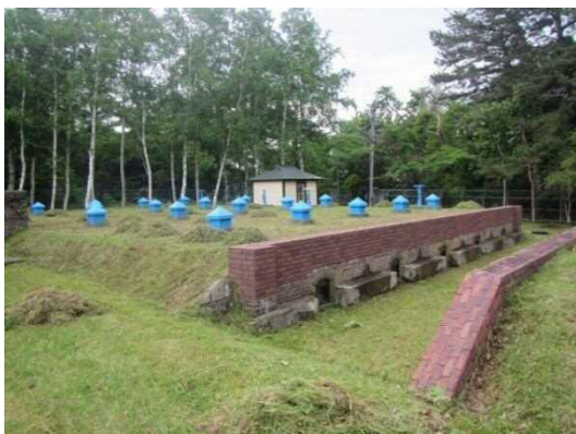
写真 3-3 飯詰 2 号配水池
