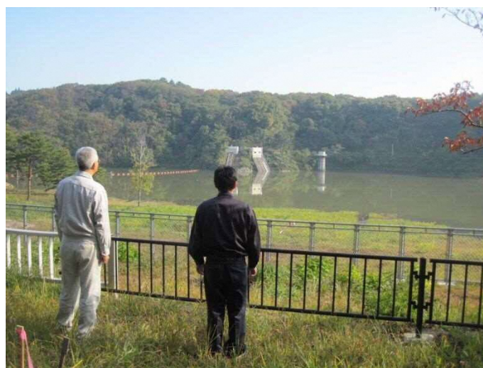
写真 3-2 水源パトロール状況(飯詰ダム)
