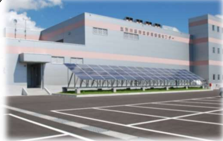
学校給食センター建設事業 起債額:約28億円(H25~28年度)
