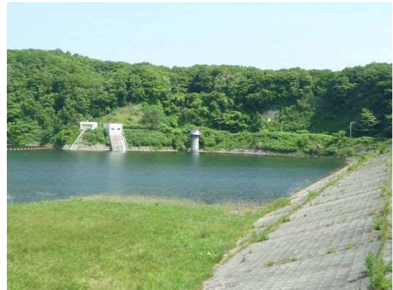
写真 2-2 飯詰ダム (ダム水)
