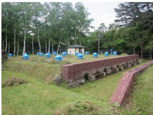
写真 3-3 飯詰 2 号配水池
