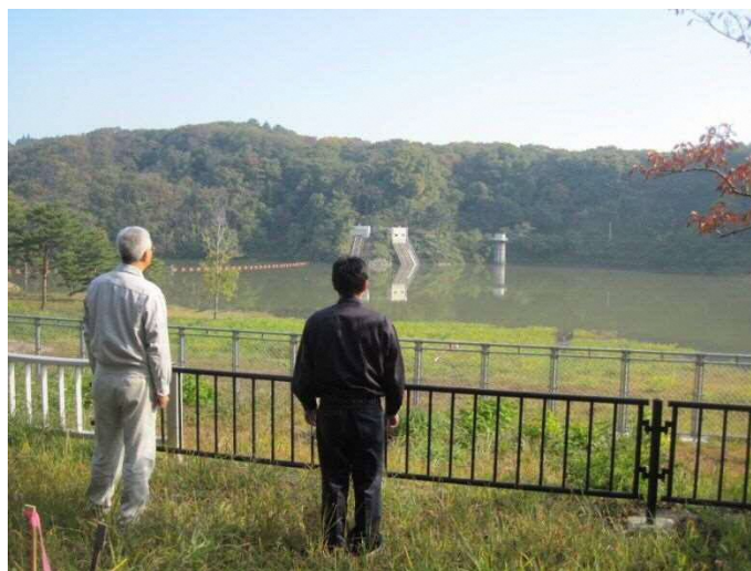
写真 3-2 水源パトロール状況(飯詰ダム)
