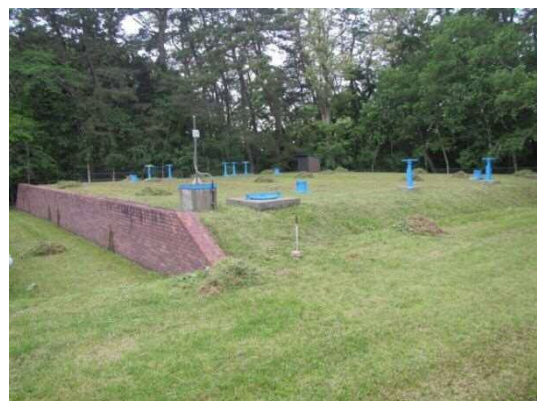
写真 3-4 飯詰 1 号配水池
