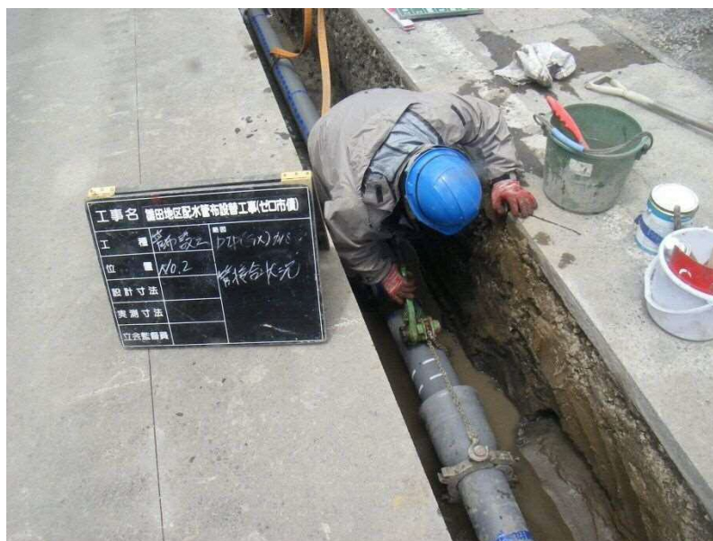
写真 3-5 耐震管路の施工状況(耐震継手GXの施工)
