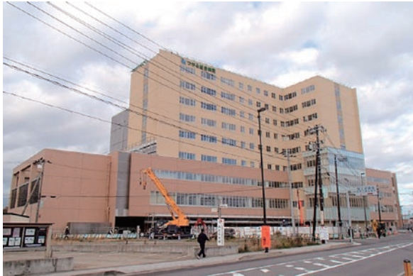
建設中のつがる総合病院
