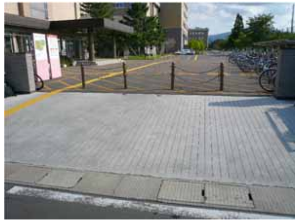
弘前大学内地熱利用設備
