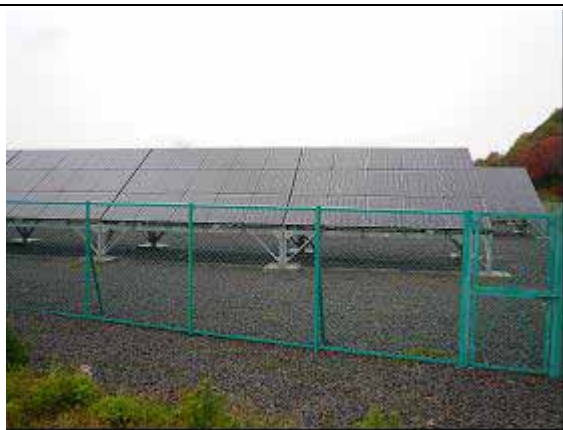
太陽光発電パネル（167W×300台）
