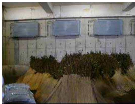
壁に設置されている冷熱パネル
