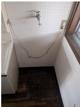
1階 洗濯機置場
