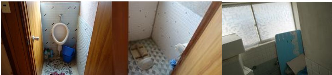
1階トイレ①
