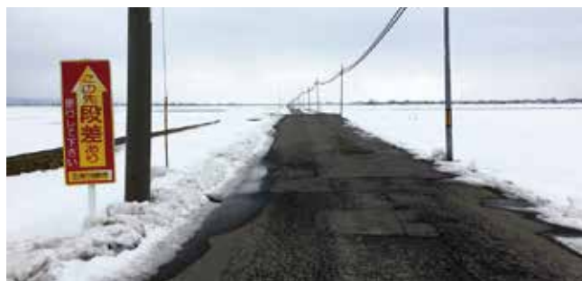
段差が生じている市道鶴ヶ岡・藻川線
