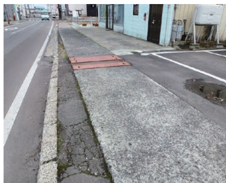
鎌谷町内の歩道
