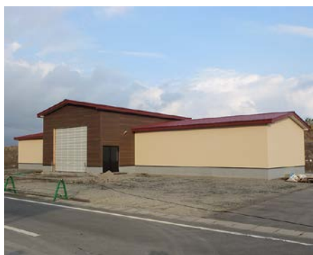
完成間近の十三地区水産物冷凍施設
