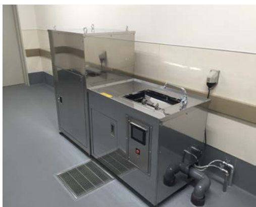
新学校給食センターに設置される 厨芥処理機
